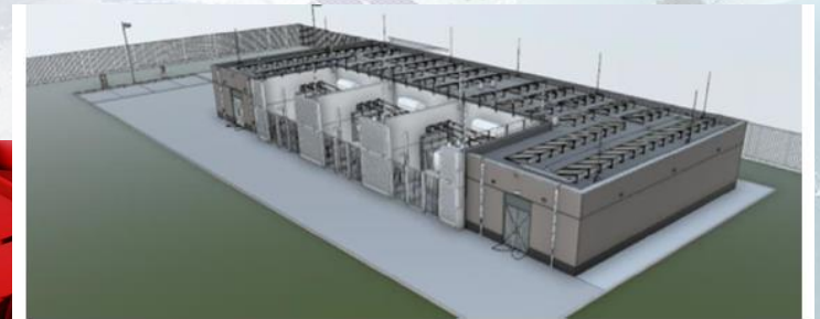
Modulair opgebouwd: schakelstation Lelystad
