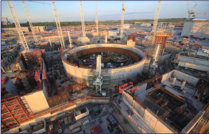
De bouw van een nieuwe kerncentrale van EDF in Hinkley Point, aan het kanaal van Bristol. © EDF
