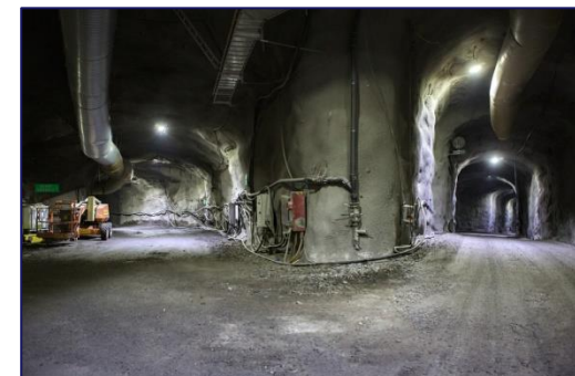
De bouw van een testtunnel
